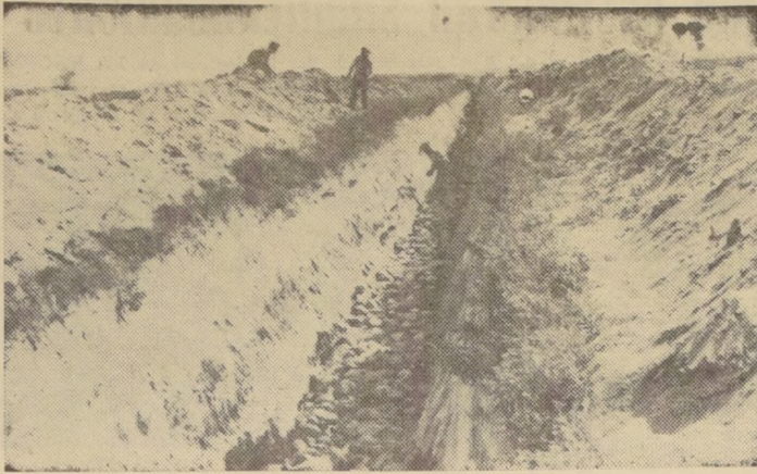
Kilómetros de trincheras ha excavado la Corporación de la Reforma Agraria, en el valle del Lluta, para drenar los terrenos pantanosos, donde sólo crecía la totora, y convertirlos en aptos para el cultivo. La zanja se cubre con grandes piedras y se vuelve a tapar. Por ella se escurre el agua, que no es aprovechada después en los cultivos, por ser salobre. (Foto de Carmen Merino.)
