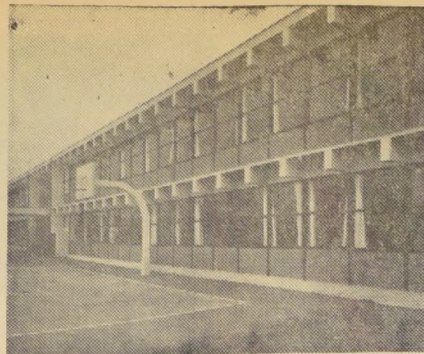
SAN FERNANDO.— NUEVO LOCAL ESCOLAR.— Este moderno edificio, en que funcionará la Escuela Técnica de San Fernando, será inaugurado hoy, con asistencia de autoridades educacionales y locales. Su construcción forma parte del plan de Gobierno para dotar de nuevos edificios a las escuelas del país.
