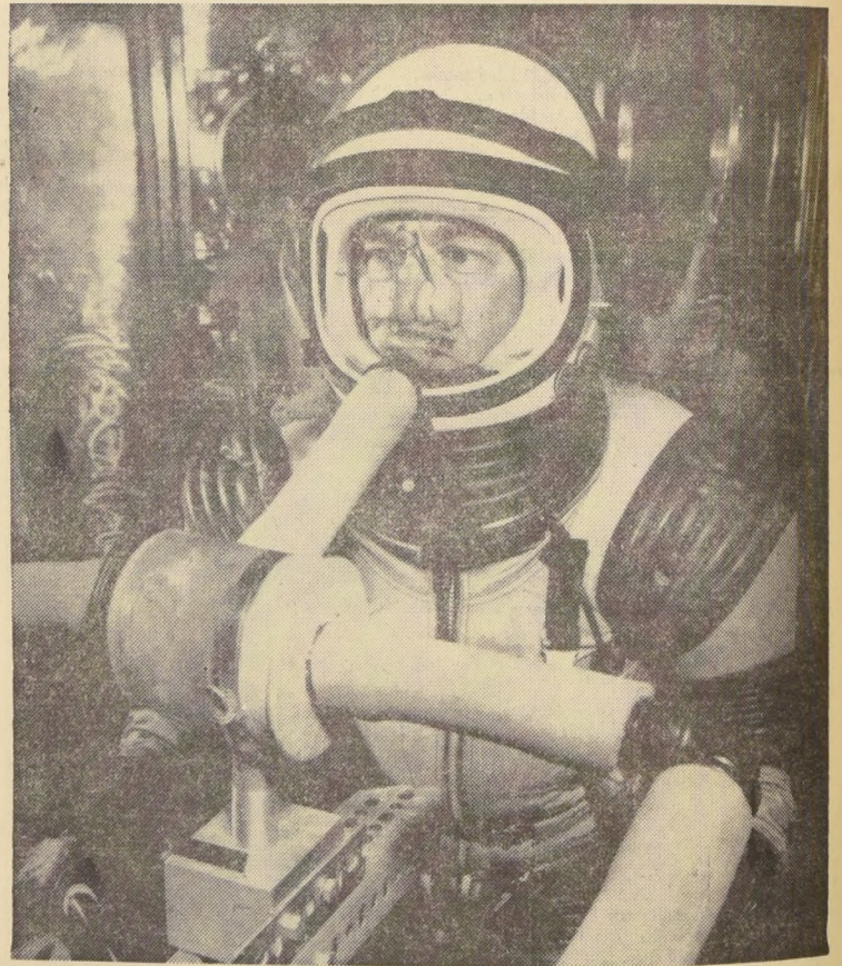
ARRIBA: Un ingeniero español de la Republic Aviation Corporation aparece aquí ensayando un nuevo traje proyectado para los astronautas norteamericanos del programa de vuelos Apollo, destinado a hacer llegar velozmente los tripulados a la Luna. El ingeniero, provisto de un dispositivo respiratorio, pedales en una bicicleta espacial. En el laboratorio de investigación de Farmingdale, Nueva York, la mencionada institución está experimentando con diversos metales y técnicas para la fabricación de trajes espaciales, así como en estudios de movilidad, en relación con los futuros vuelos del hombre a la Luna.
