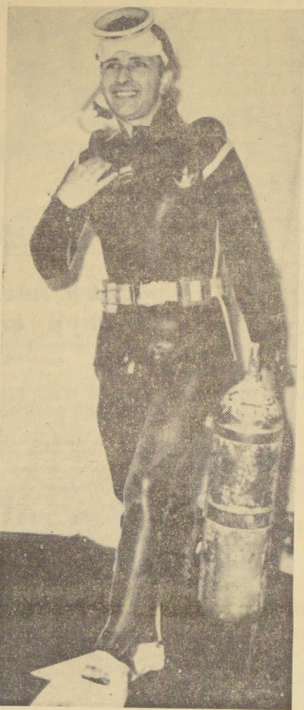
El traje de neopren de un hombre-rana es tan ajustado, que se coloca con polvos talco. Vale $ 1.000, pero sus ventajas son múltiples: preservan del frío, aíslan totalmente al nadador del agua, las aletas le dan velocidad y el tubo con aire le asegura una hora de labor bajo el agua sin dificultades respiratorias. Carlos Calderón demuestra que además de útil, la vestimenta es chic.
