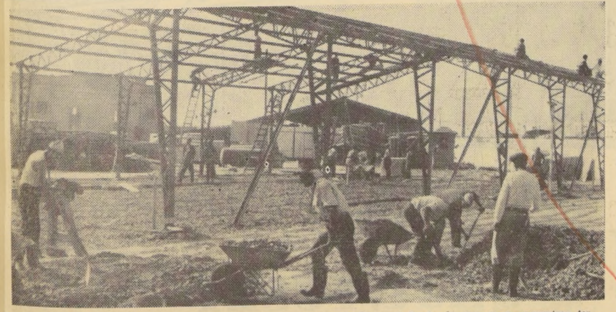
La fotografía corresponde a los trabajos de construcción de los galpones auxiliares para la Planta de la Empresa Pesquera de Tarapacá S. A., los que ya se encuentran terminados.
