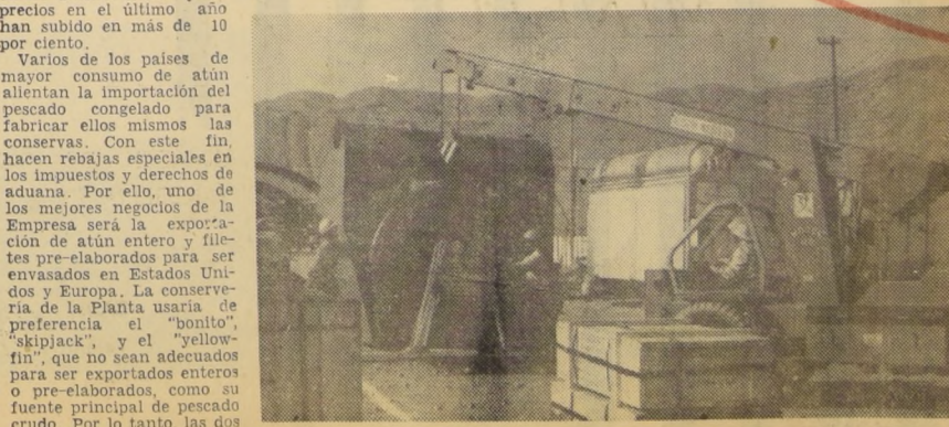
En plena labor se encuentran los preparativos para el montaje definitivo de la Planta de Harina de Pescado de la Empresa Pesquera de Tarapacá S. A. En el grabado, una grúa de la empresa ubicando los equipos de la Planta de Harina de Pescado, la que cuenta una capacidad de producción de 30 toneladas por hora.
