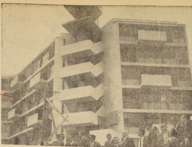
VALPARAÍSO.- NUEVA POBLACION CORVI.- En los faldeos del Cerro Lecheros de Valparaíso, se está poniendo término a la construcción de la Población Lecheros, que constituye un nuevo aporte habitacional para el progreso de nuestro puerto. El intendente de la provincia, don Luis Guevara, acompañado de personas de CORVI, efectúa una visita de inspección a los trabajos que se realizan en este sentido. EN EL GRABADO, un aspecto de la moderna población que será inaugurada próximamente.
