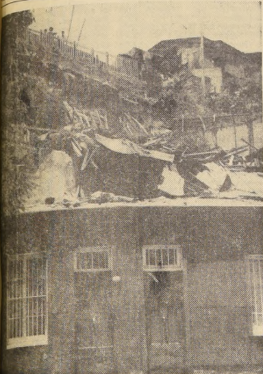
PARAISO.—DERRUMBE DE UNA CASA.— Todo el edificio de una casa del cerro Yungay, se desmoronó a las 10 de la madrugada de ayer, causando alarma entre los vecinos y una gran angustia en la familia que ocupaba el inmueble. Todos ellos quedaron heridos, el matrimonio Hidalgo y sus dos hijos de corta edad. El derrumbe lo provocó una grieta que inundó los muros de la vivienda. EN EL GRABADO, un elocuente gráfico del accidente.
