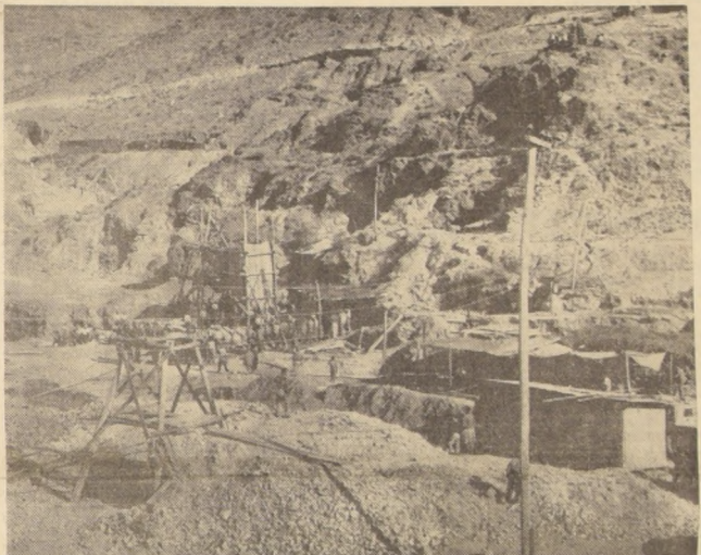
Un aspecto de la mina "Flor de Té", donde se produjo el derrumbe que tiene atrapados a siete mineros. Los esfuerzos para rescatarlos se mantienen con la intensidad del primer día. Ayer se logró contacto con los cinco que se
