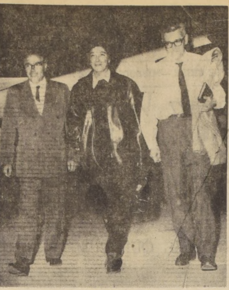
EL MINISTRO de Obras Públicas, Ernesto Pinto Lagarrigue (derecha), a su regreso de una visita que realizó a las provincias de Cautín y Valdivia, para imponerse de los daños producidos por los deshielos que ocasionó la erupción del Villarica. Lo acompañaron la diputada Inés Henríquez, y el jefe del Departamento de Puentes, Darwin Lois.
