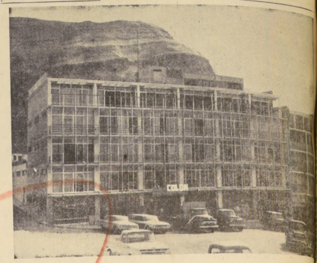
En este edificio tiene su sede la Junta de Adelanto de Arica. En sus oficinas se reúnen los miembros de la Junta, para resolver el progreso de esta zona, que está alcanzando un halagador nivel de desarrollo. También, además, de otras entidades, el edificio cuenta con un cine, el Colón, que constituye de los sitios preferidos de los ariqueños.
