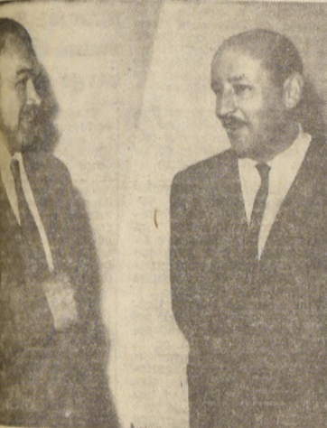
ALDE DE CONCHALI PEDIRA: El ingeniero Ramón Lehué informó al diputado Lehué y sus acompañados que se habían superado las dificultades que existían en el cantarillado de la Quinta Normal, y que se iniciarán los trabajos de construcción del colector Mapocho y del colector-emisario Salvador Gutiérrez, en esta comuna.
