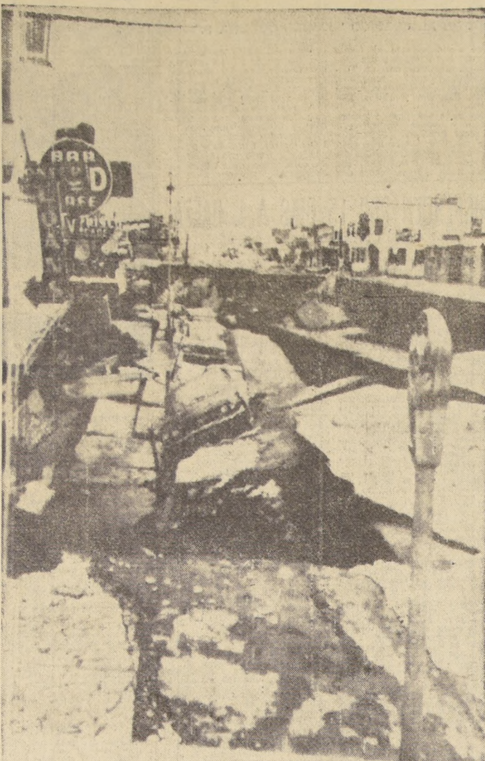
ANCHORAGE, Alaska. — La escena es una elocuente muestra de la magnitud alcanzada por el terremoto que afectara a Alaska el 28, y cuya ciudad más dañada fue Anchorage. Se, que suifera destrozada en un 50 por ciento de sus construcciones. La calle que se observa en el grabado, sufrió desvíes en su tramo de cerca de seis metros, como se ve los automóviles parecen estar en un barranco, lo que era antes el mismo nivel de las viviendas de la derecha. — (Radiofoto UPI).
