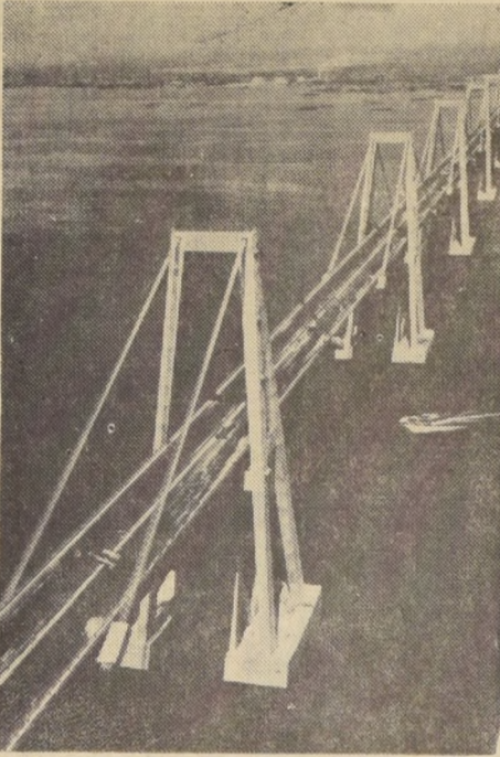
UNA IMPOSANTE VISTA DEL PUENTE "GENERAL RFAUll URDANETA", sobre el Lago Maracaibo, cuyo tramo central de 182 metros, se derrumbó sobre las aguas al ser chocado por un supertanque petrolero. Este puente, inaugurado el 24 de agosto de 1962, tiene una longitud de 8 kilómetros 678 metros. La construcción se extiende desde Punta Iguaña hasta Punta Piedras, frente a Maracaibo, capital del Estado de Zulia. El costo total del puente fue de 350 millones de bolívares, o sea, unos 100 millones de dólares. Sobre el canal de navegación, o sea la parte central, se extienden cinco puentes de 182 metros de luz. Este fue el tramo que se desplomó ayer después de ser chocado sus pilares.
