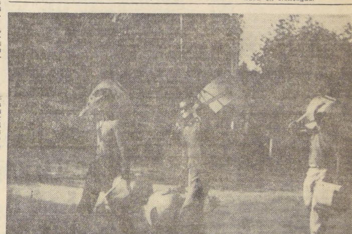
TALCA - FOCOS PARA LA ILUMINACION DEL ESTADIO FISCAL DE TALCA - Llegaron a nuestra ciudad los focos que, anteriormente estaban instalados en el Estadio Nacional de Santiago. Estos serán destinados a la iluminación del Estadio Fiscal, que administra Carlos Reyes Aravena. El material que se ve siendo trasladado, por obreros, fue obtenido por gestiones del Subsecretario del Ministerio del Interior, Jaime Silva. Con dicho equipo eléctrico se solucionará el problema de buena iluminación de nuestro principal campo de deportes.
