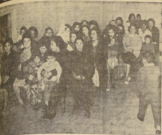
LAS BARRANCAS.—CONSULTORIO INTEGRAL. —El martes pasado, el SNS entregó oficialmente al servicio de la comuna de Barrancas, un Consultorio Integral, que
