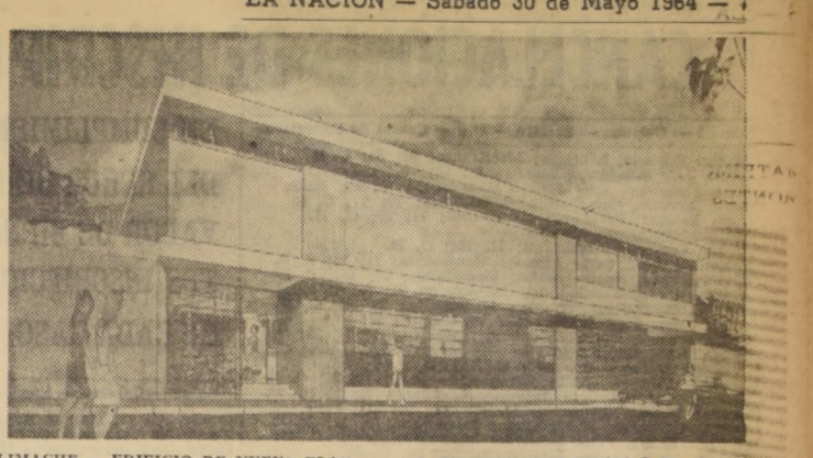
LIMACHE — EDIFICIO DE NUEVA PLANTA TELEFONICA. — Con un costo de 500 millones de pesos fue construido el edificio y se adquirieron las instalaciones de la nueva planta de la Compañía de Teléfonos, que se inaugura esta tarde en esta ciudad. En el grabado, aparece la fachada del nuevo edificio, cuyas instalaciones vendrán a aumentar en más de un 100 por ciento las líneas telefónicas que contaba la región.
