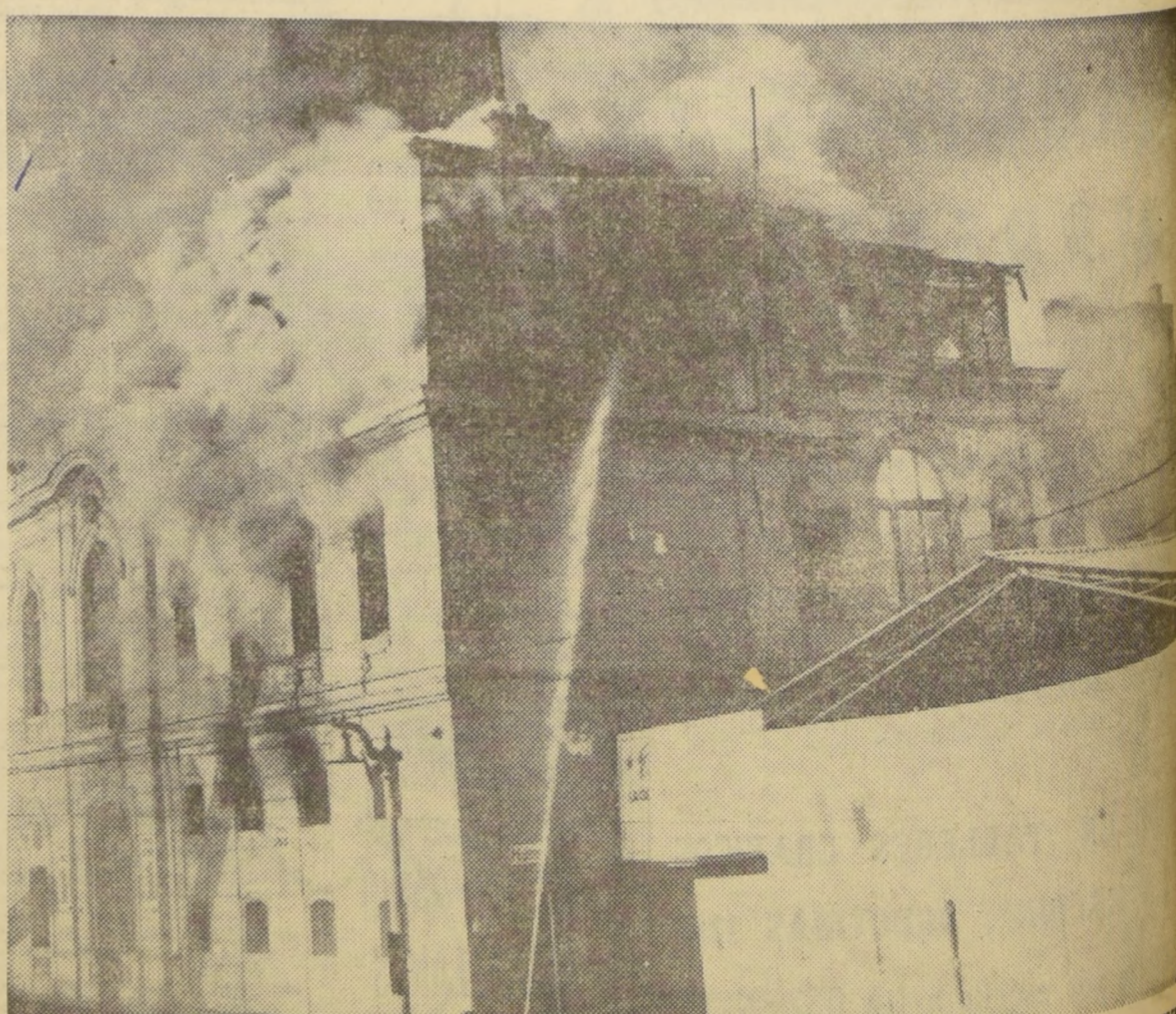
Un incendio redujo a escombros el local de la Secretaría General del FRAP, ubicada en Catedral esquina de Teatinos, el lunes 21 del presente. Las llamas hicieron rápidamente presa de la estructura del viejo edificio, ocasionando grandes pérdidas. En el grabado se ve la acción de los bomberos para atacar el fuego, lo que no impidió que las llamas hicieran labor destructora.
