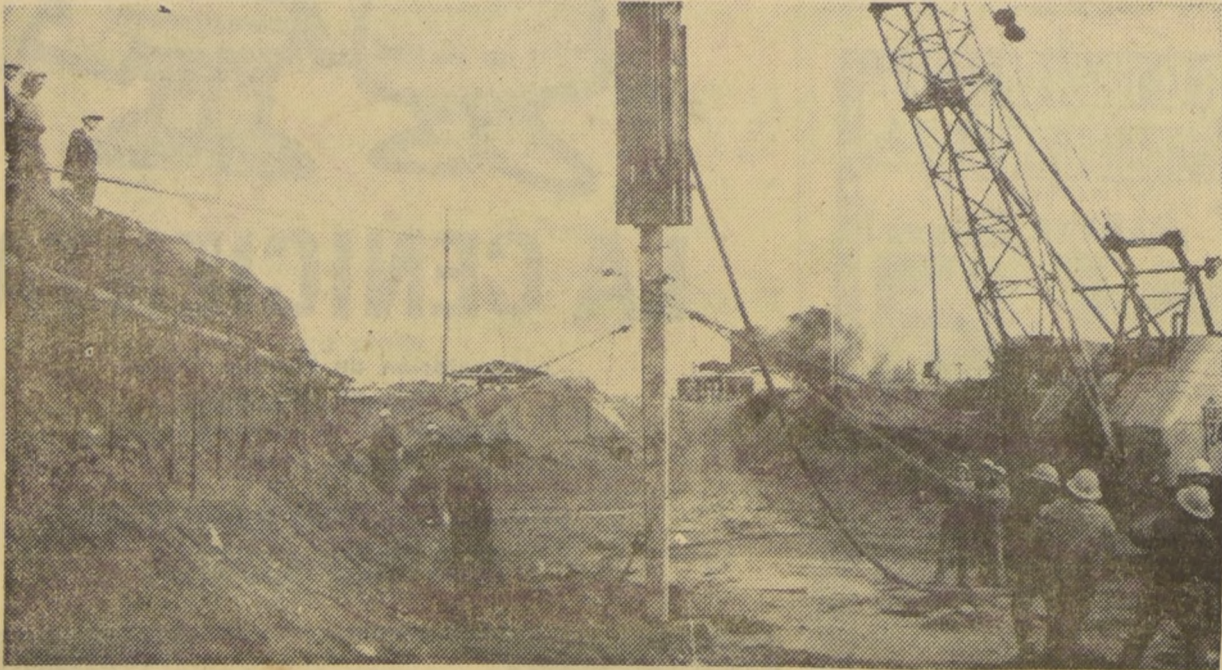
Acceleradamente se está trabajando en la Planta de Huachipato, en la preparación del terreno para la construcción de un segundo alto horno en esa usina, que permitirá en el futuro duplicar la capacidad de producción de arrabio de nuestro país. En el grabado, se introducen pilotes, para asentar el suelo.
