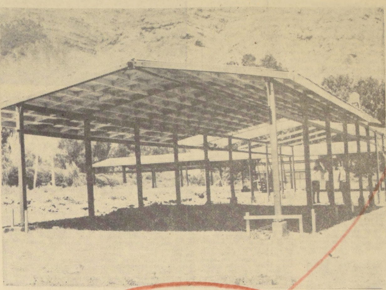
Un aspecto de la obra gruesa del edificio que la Sociedad constructora entrega a las comunidades, plan que representa una solución importante en el problema de construcciones escolares.
