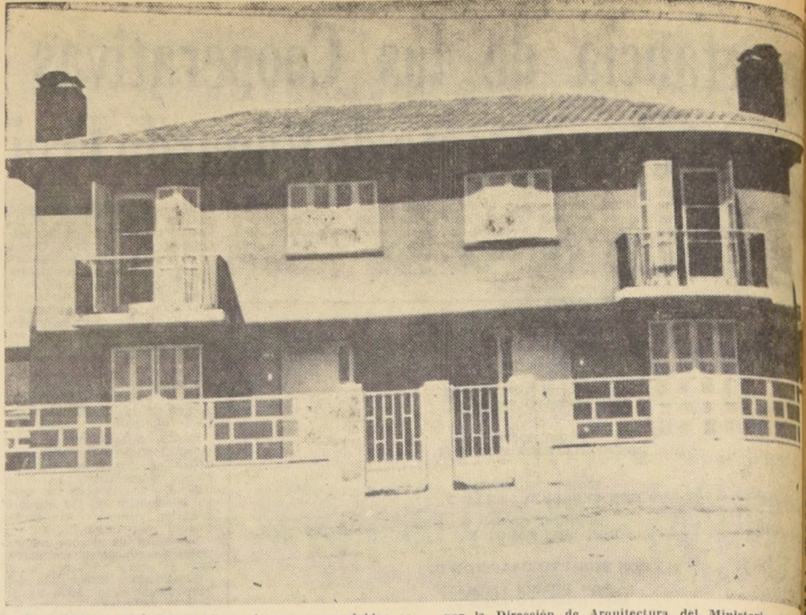
DE LINEAS ACOGEDORAS, modernas y agradables es el edificio del Cuerpo de Bomberos de ValLENAR, construido por la Dirección de Arquitectura del Ministerio de Públicas.
