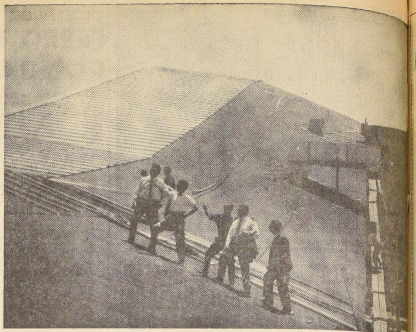
SOBRE LA TECHUMBRE del Estadio Chile, que deberá quedar terminada el próximo mes de diciembre, el contratista de la obra, Mario Mellado del Pino; el arquitecto Jorge Patiño,
