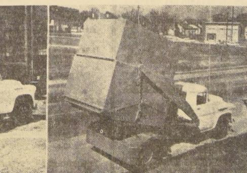
El mecanismo de grúa, coloca el "container" en posición de vaciado.
