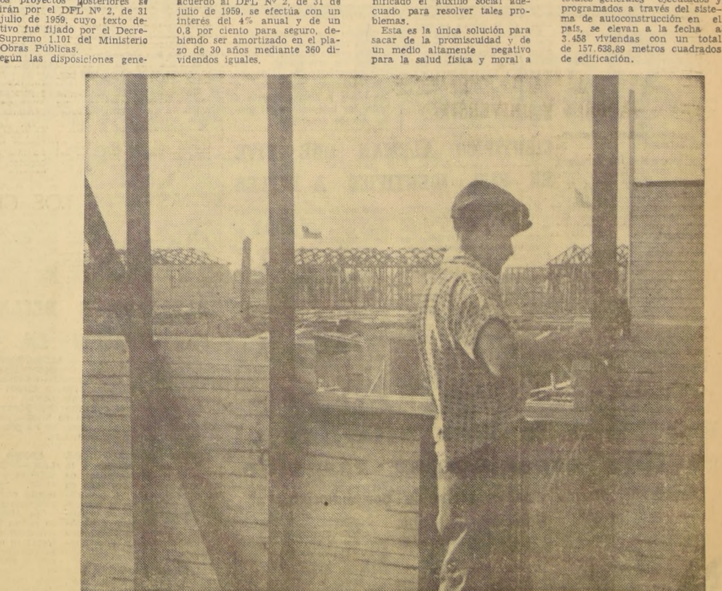
Viviendas en avanzada etapa por el sistema de autoconstrucción en "Lo Valledor Sur", lucen el tradicional embanderamiento de los tijerales.
