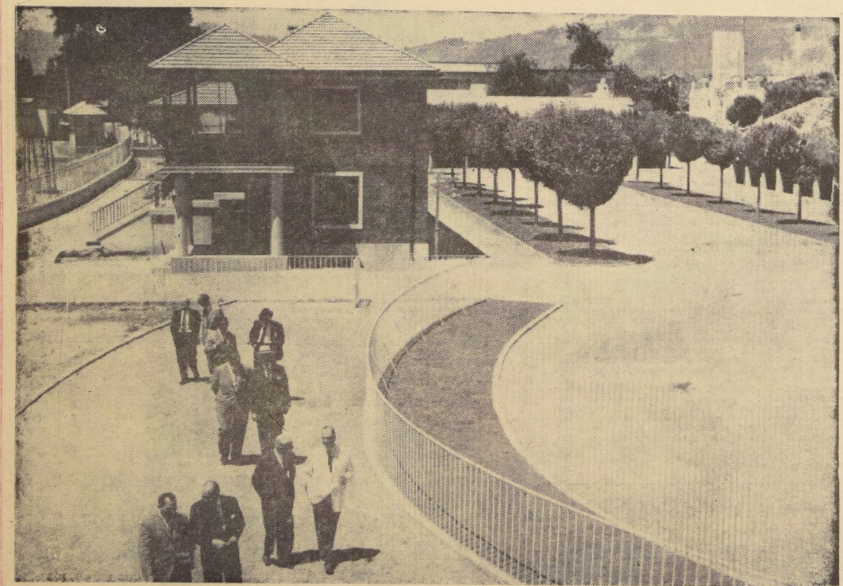
LA SALA DE JINETES , el recinto de los Comisarios, el Casino para los profesionales y la Clínica Médica, fueron inauguradas hace dos años en medio del general beneplácito de todos los sectores. Es una construcción moderna, bien realizada y mejor diseñada. Un auténtico orgullo de la institución palmeña.
