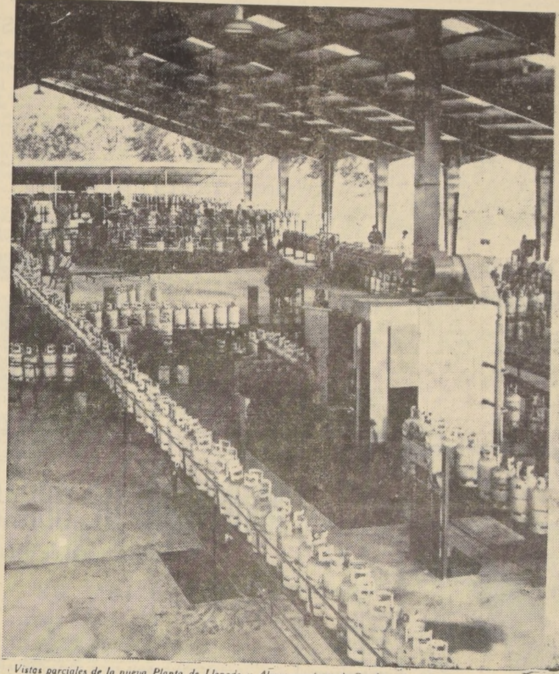
Vistas parciales de la nueva Planta de Llenado y Almacenamiento de Gas Licuado, inaugurada hoy por GASCO en Maipú.
