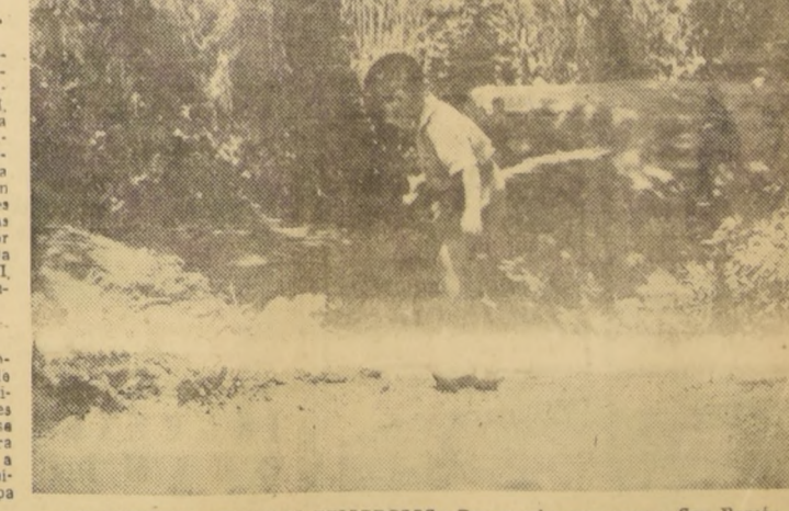
LA CISTERNA. CANALES PELIGROSOS.— Dos canales que cruzan San Ramón Antiguo, corriendo sus aguas a tajo abierto por la Avenida Manuel Rodríguez, constituyen un peligro mortal para los niños de este populoso sector de La Cisterna, habitado por 35.000 personas. Los reclamos formulados por las organizaciones vecinales a la Asociación de Canalistas de Maipo, se han estrellado con una indiferencia total de sus dirigidos. En la actualidad los vecinos esperan que con la construcción del camino de Circunvalación, el Estado deba abovedar este canal, salvo que se propicie una reforma del Código de Aguas, para obligar a las sociedades canalistas a proceder al abovedamiento de sus canales de riego, cuando sean un peligro para la comunidad. EN EL GRABADO, el niño Ubaldo Zapata salta un pequeño derrame de agua entre los dos profundos canales que corren a tajo abierto por Avenida Manuel Rodríguez, demostrando una pericia inusitada, pues perder el equilibrio significaba correr el riesgo de morir ahogado.
