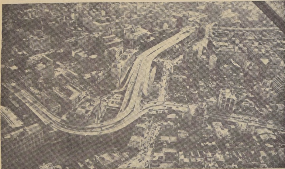
AUTOPISTA elevada que atraviesa Tokio.
