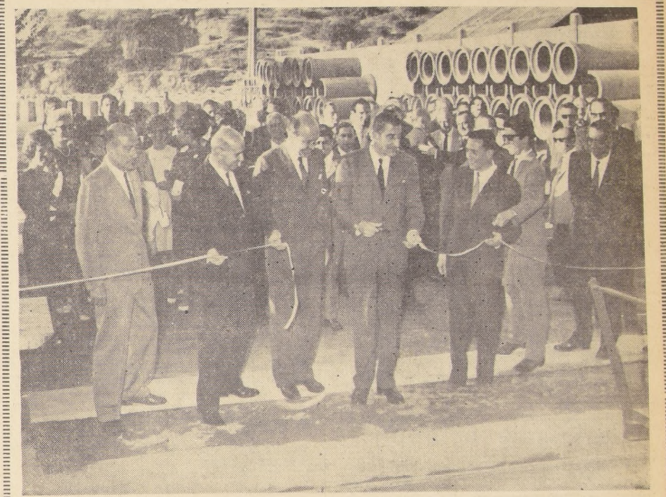
El Presidente Eduardo Frei, acompañado de sus Ministros de Economía y Obras Públicas, inauguró ayer, a las 18:45 horas, la nueva maquinaria de la firma Vibrocet Fresca, ubicada en el camino Lo Errazuriz, en Los Cerrillos. Vibrocet, productora de ladrillos de arena silicea, de gran aislación y termicos, es una industria formada con pequeño capital privado y aportes de la CORFO. Su producto, a base de materia prima nacional, está destinado a la construcción y al mejoramiento de los barrios, fabricando postes para la electricidad y tubos de
