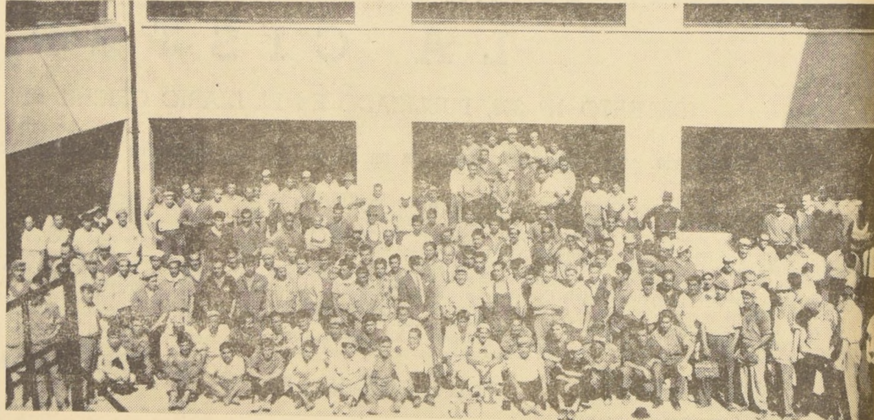
Con motivo de estar pronto a terminarse el primer cuerpo del nuevo edificio del Instituto Nacional, un grupo de operarios de la firma DESCO y otros que trabajan por administración en diversos aspectos de la obra, posaron alrededor del Rector Clemente Canales y del arquitecto Lutgardo Jofré. También están en la fotografía los contratistas y técnicos de la obra. La foto fue captada en uno de los patios de preparatorias.
