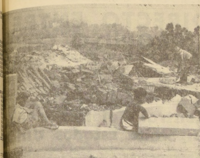
VALPARAISO.— Pasado el mediodía de ayer, la Municipalidad y regidores del puerto de Valparaíso se prepararon para entregar las primeras viviendas provisionales a los damnificados...
