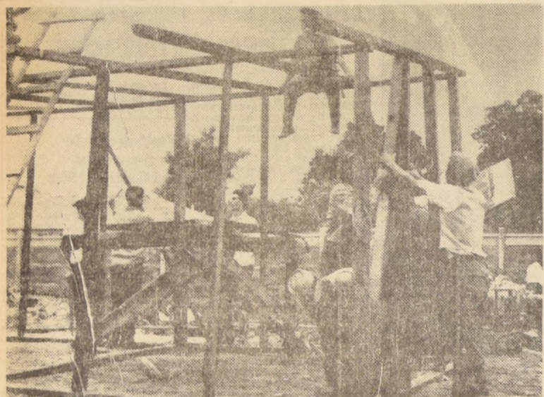
AUTOCONSTRUCCION. — Los esfuerzos de estudiantes y obreros se suman en los trabajos de autoconstrucción en la zona del sismo. Esta foto, tomada del Hospital viejo de Quillota, muestra a los obreros —jefes de familias damnificadas—, junto a estudiantes de Ingeniería de la Universidad de Chile. Levantan las viviendas con materiales de las demoliciones de las mismas casas afectadas.
