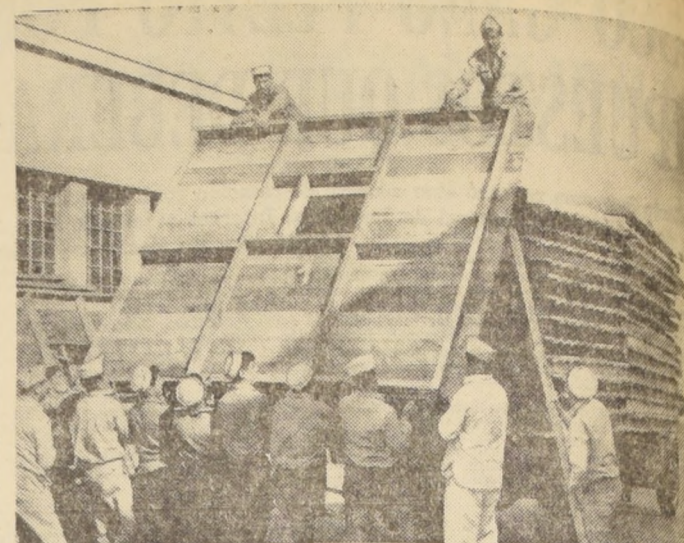
VALPARAISO.— PANELES PARA NUEVA POBLACION — Ayer se inició la construcción de 20 viviendas de emergencia en el alto de Playa Ancha, en un lugar que quedará convertido en un gran centro de nuevas poblaciones, al levantar en el sector municipal 200 casas para su personal y 600 la CORVI, para continuar después con un número mayor. EN EL GRABADO, aparecen los paneles de las casas de emergencia, que serán enviados desde la planta de construcción de calle Chacabuco a Playa Ancha.
