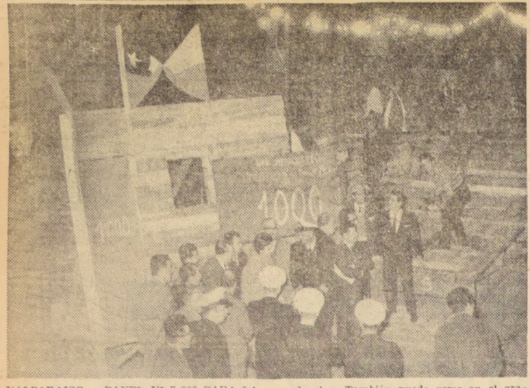
VALPARAISO. — PANEL N° 7.000 PARA LA CASA N° 1.000.— En el grabado puede verse el panel 7 mil correspondiente a parte del frente de la casa N° 1.000 construida por la fábrica instalada en calle Chacabuco de este puerto, y que fue entregada en un acto efectuado anteanoche. En cada casa de emergencia entran 7 paneles: cuatro para los frentes y partes posteriores, dos para los costados y uno que sirve para dividir la vivienda en dos piezas. El techo de estas casas
