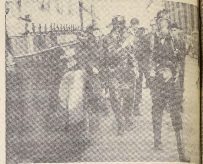
AMAGO DE INCENDIO EN EL S. S. S.— A las 10.55 horas de ayer, el empleado del Servicio de Seguro Social, Juan Miguel Bruna dio la alarma de incendio en el edificio antiguo, ubicado en el subterráneo, calle Morande 107. Los bomberos no prestamente y sofocaron el fuego de poca monta. El origen del fuego se debió a una explosión producida por el obrero Héctor Rojas Campoverde, el que realizaba trabajos de reparación en los tubos de la calefacción. EN EL GRABADO, bomberos con máscara contra gases, momentos después de haber hecho abandono de las faenas en el subterráneo, ya dominado el siniestro.
