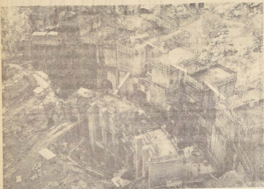
EN EL GRABADO, en primer plano, la concreción de la estructura de la casa de máquinas, donde irán colocadas las cinco unidades de 70.000 kw de la central eléctrica de Rapel. En segundo plano, la estructura del muro que se preparará las aguas del Rapel, en la garganta de Queiantaro,
