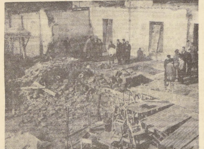
Estado en que quedó la vieja construcción donde funcionaba la Escuela Pública N° 217 de Renca, luego de producido el derrumbe que causó la muerte de dos obreros...
