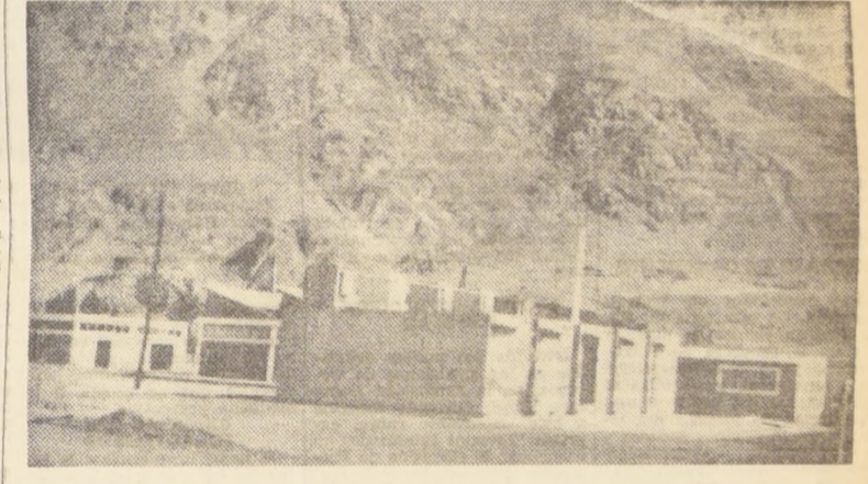
TALTAL.— Parte de las instalaciones para la industria pesquera que dará vida a este puerto que conoció mejores días en los años del oro blanco. Pesquera ALGAMA S. A. al adquirir a la CORFO algunas instalaciones las está completando ahora con nuevos elementos para montar una moderna Planta de Harina de Pescado y Aceite. Esta industria permitirá que Taltal cuente con una fuente de trabajo especializado y bien rentado.
