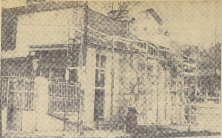
VALPARAISO — REPARACIONES EN EL LICEO EDUARDO DE LA BARRA. — Se efectúan actualmente reparaciones en el Liceo de Hombres "Eduardo de la Barra" de este puerto, las que se hallan suficientemente avanzadas. El local del Liceo, que se
