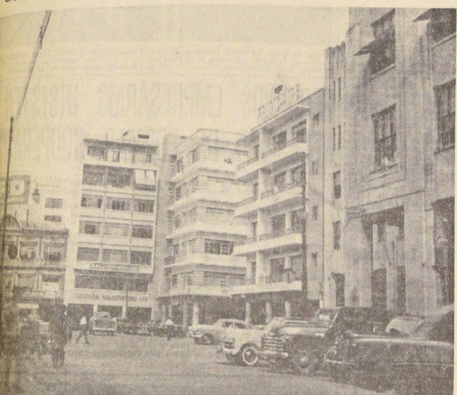
MODERNAS CONSTRUCCIONES en la Plaza de San Francisco Guayaquil. En el principal de la derecha funciona el Consulado General de Chile.
