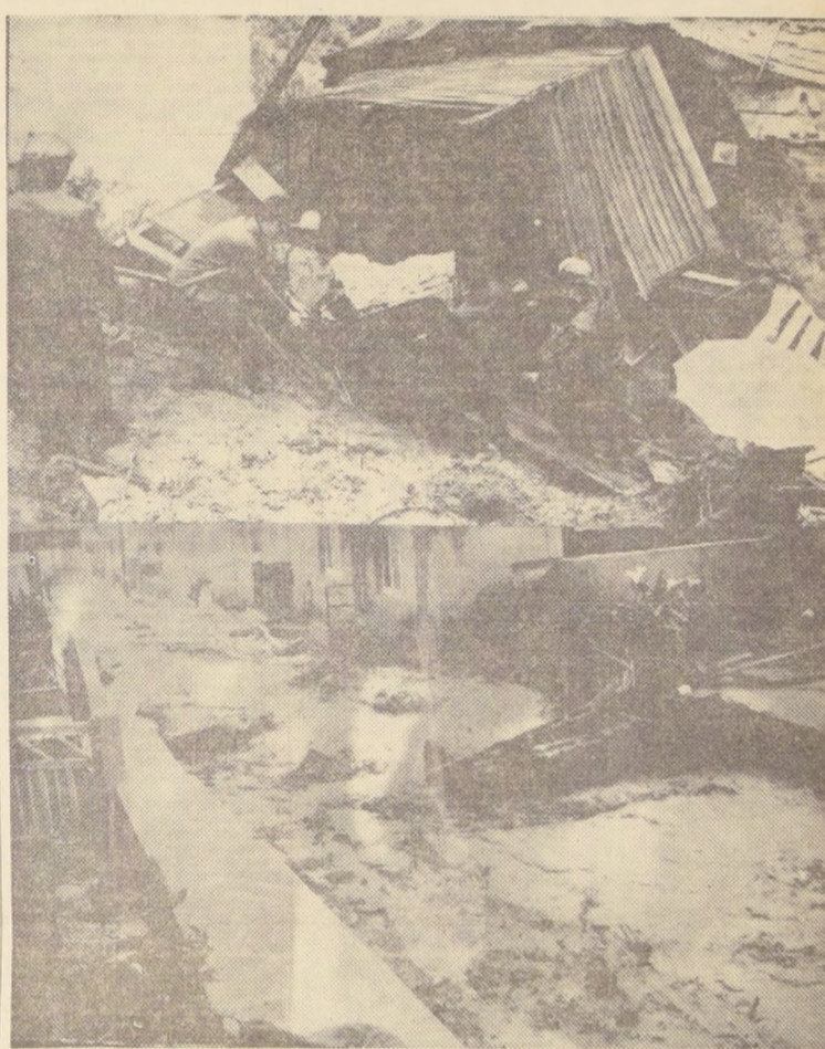
VALPARAISO.— DERRUMBES POR EL TEMPORAL.— El temporal que azota Valparaíso con inusitada fuerza ha ocasionado numerosos derrumbes en la parte alta de los cerros, tanto de Viña como de Valparaíso. Centenares de familias deberán ser evacuadas de las viviendas que siguen amenazadas con desplomarse sobre sus moradores. Carabineros, bomberos, elementos municipales y de la Defensa Civil, han debido desplegar una labor incansable para acudir en auxilio de los angustiados moradores, cuyos llamados siguen llegando. En los gráficos, dos aspectos de los desastrosos efectos del temporal en tierra: en el primero, una casa desplomada en Santos Ossa, en este puerto, y en el segundo, calle Inés, de Recreo, convertida en un torrente de barro y pedras, lugar en que se derrumbó otra casa.
