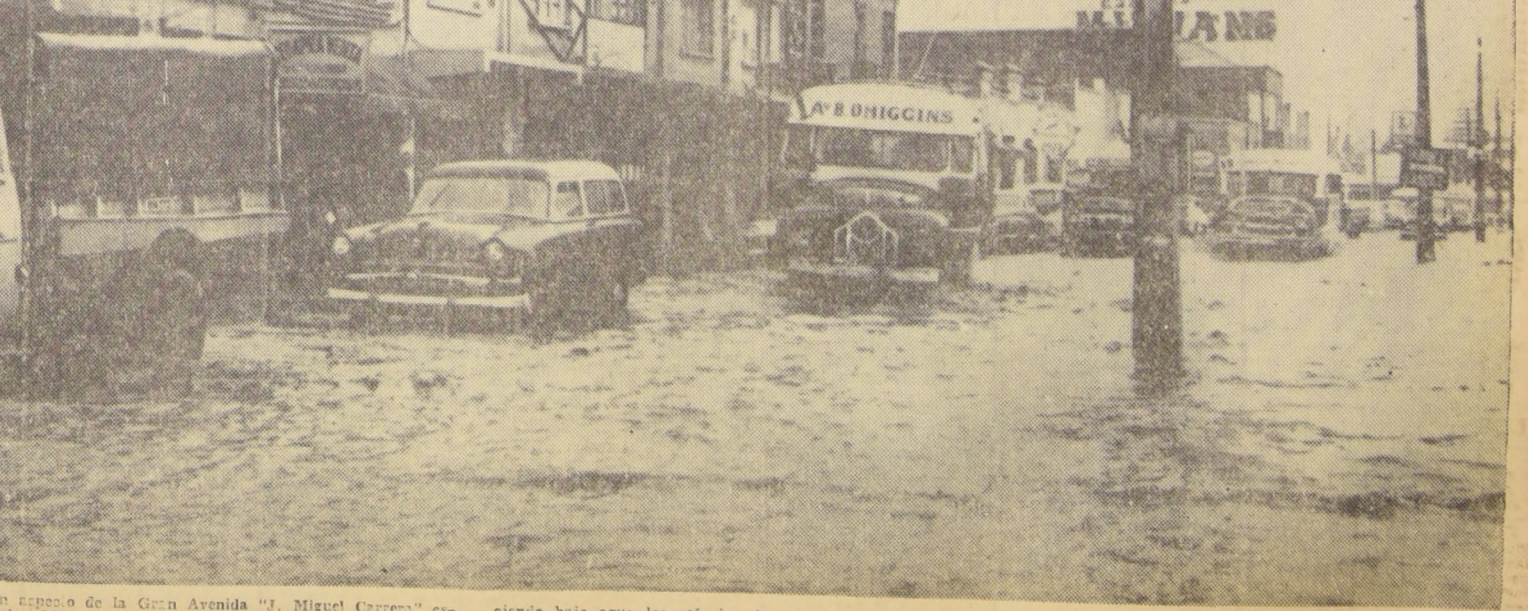
Un espacio de la Gran Avenida "J. Miguel Carrera" esquina Milán donde la lluvia inundó la ancha vía, sumergiendo bajo agua los refugios de peatones instalados en medio de la calzada, donde están instalados los postes del alumbrado. Verdaderas marejadas cruzan la arteria.
