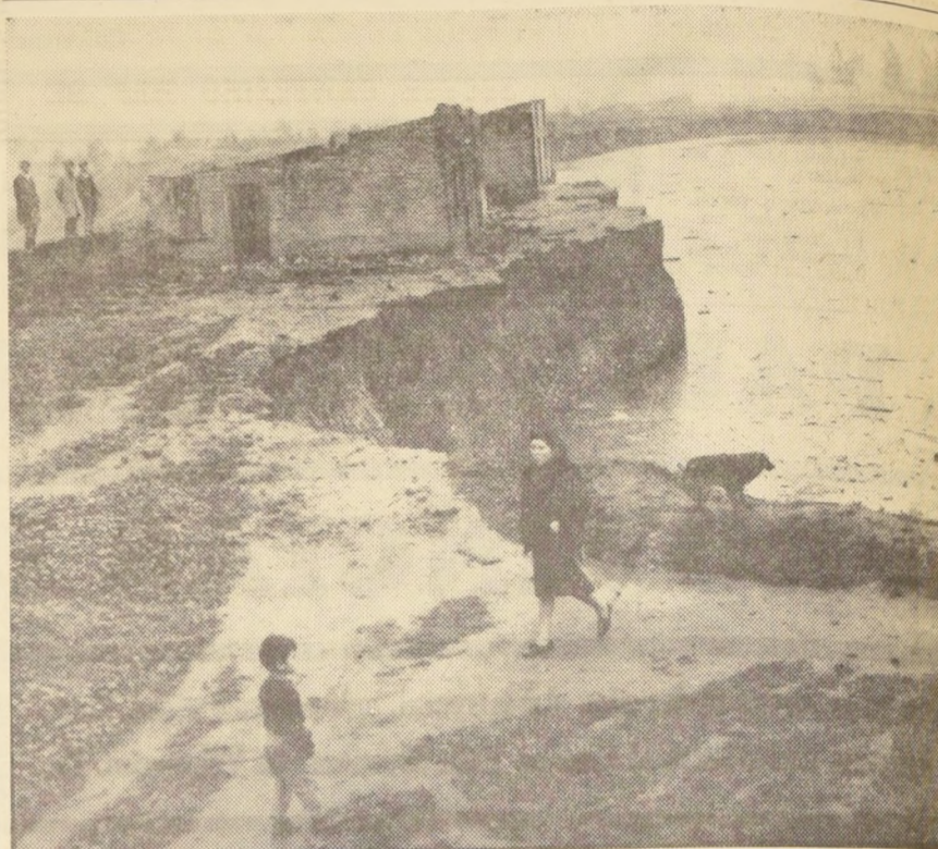
Las tranquilas aguas de la laguna Lo Errázuriz, en Cerrillos, se han transformado en un elemento destructor peligroso, como consecuencia del intenso temporal que azota al país. Dos viviendas fueron arrasadas y ahora están a diez metros de profundidad. EN EL GRABADO, estas dos correrán la misma suerte; 16 personas de ellas abandonadas a las dos de la madrugada del jueves, el peligro inminente de que el agua siguiera creciendo el riesgo que las sostiene. A LA DERECHA, se observan los restos de una de las casas sumergidas.
