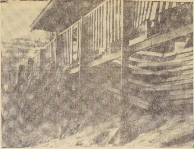
VALPARAISO.— INUNDACION Y DESTROZOS EN ESTACION RECREO.— A los grandes perjuicios que el oleaje causó en la Estación Recreo, entre Valparaíso y Viña del Mar, se suman ahora los efectos catastróficos de la inundación que afectó ayer a ese lugar. La lluvia, que con violencia implacable se descargó sobre la zona, convirtió en un río a la Avenida España frente a Recreo, aumentando el canal de agua con las verdaderas cataratas, que como se ve en el grabado, caían desde la plataforma de la asfaltada estación.
