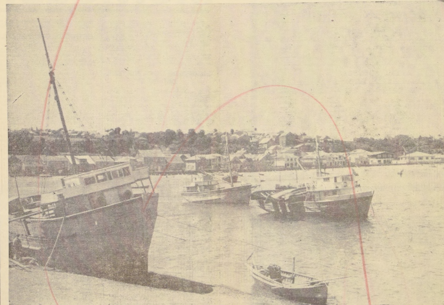
EN EL GRABADO, una hermosa bahía en la isla de Calbuco, del sector denominado La Vega, barrio de singular atractivo en que se encuentran instaladas algunas de las once fábricas de conservas con que cuenta Calbuco. Es posible apre-
