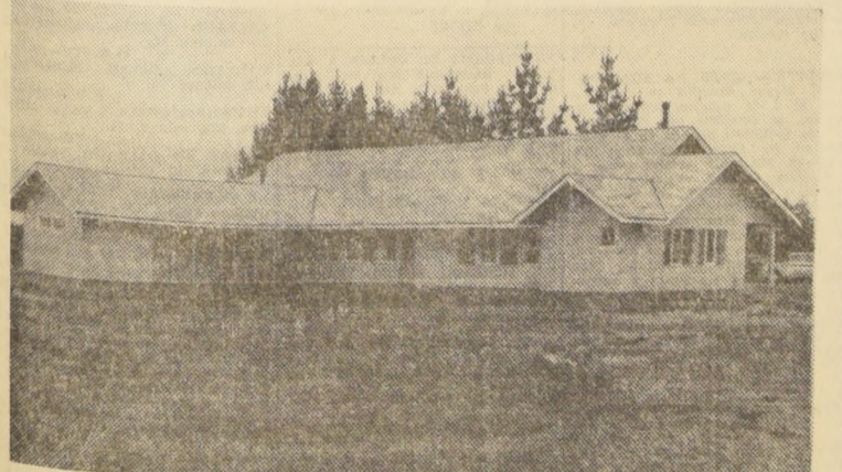
Recientemente fue inaugurada en la localidad de La Radio, provincia de Llanquihue, la Escuela N° 44 que consta de tres espaciosas salas, con capacidad para 120 alumnos. En su construcción se emplearon materiales de la zona y planos tipos, lo que permitió una gran economía en los costos. Los forros y los interiores de las salas de clases están hechos de maño. A la parte externa se le puso una capa gruesa de pintura, mientras que las partes interiores sólo requirieron una mano de barniz. La escuela fue construida por la Dirección de Arquitectura del Ministerio de Obras Públicas.
