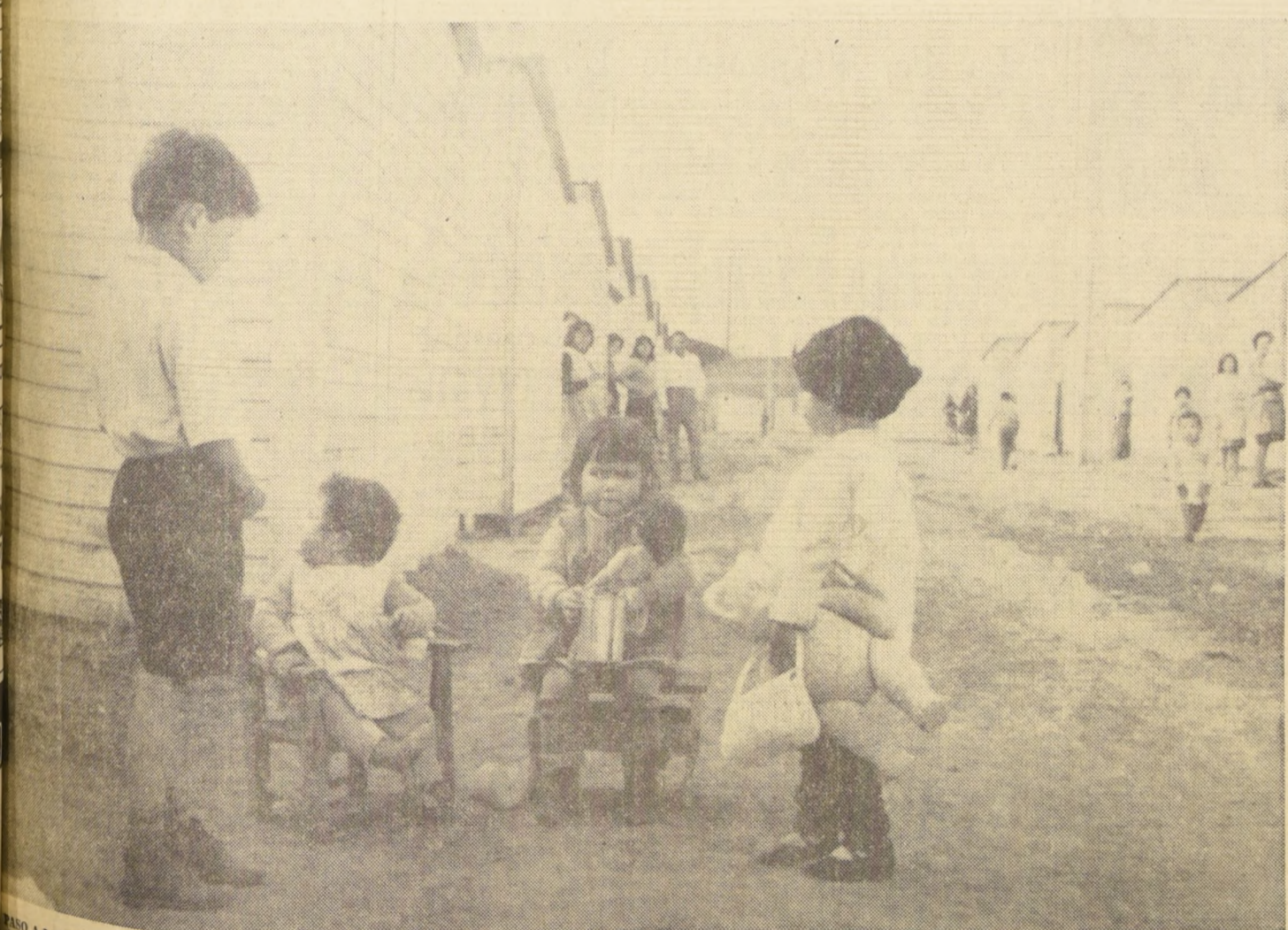
PASO A LOS NIÑOS. — El primero de octubre se iniciará la entrega de las primeras casas que está consiguiriendo la CORVI en Las Barrancas, correspondientes a la Operación Sitio y que formarán un Grupo Habitacional de 10 mil familias. Miles de modestas
