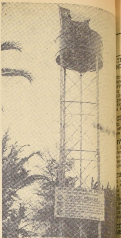
PANQUEHUE.— AGUA POTABLE RURAL.— Las comunidades rurales fueron inaugurados servicios de agua potable por la Oficina de Saneamiento del Servicio Nacional de Salud. EN EL GRABADO, se ve la torre-estaque de la planta de agua potable de Panquehue, en la provincia de Aconcagua.
