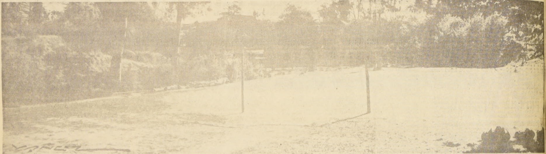
En estos terrenos estará ubicada la futura cancha de entrenamiento que tendrá Wanderers, la que dispondrá de todas las exigencias reglamentarias y por supuesto será empastada. Esta será una de las tantas construcciones que realizará el club porteño para otorgarle a la entidad un mayor crecimiento.
