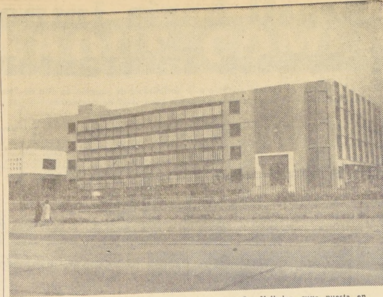
ASPECTO DEL MODERNO EDIFICIO del Matadero Lo Valledor, cuya puesta en marcha se anuncia para principios del próximo año.
