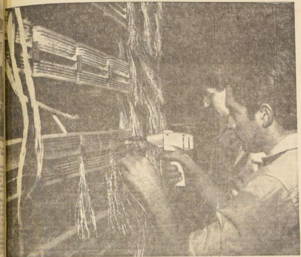
Personal especializado de la Compañía trabaja en la instalación y montaje de los equipos de conmutación de la Planta de ampliaciones, se ha dado es-
