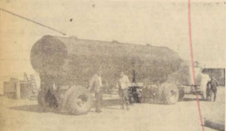
CAMIONES ESTANQUES. —Otra de las contribuciones de Maestranza CORFO-Antofagasta, a la industria nacional, es la fabricación de estanques de almacenamiento para líquidos que precisan las industrias. EL GRABADO muestra un estanque construido por dicha Maestranza para un camión encargado del transporte de líquidos que deben utilizar las industrias del país. La zona norte se ha visto beneficiada con este trabajo de la Maestranza CORFO-Antofagasta.
