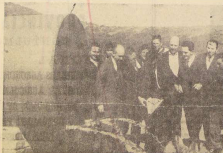
Una de las mayores preocupaciones de la Municipalidad de Viña del Mar, ha sido dotar de agua potable a los sectores populares de la comuna. El grabado corresponde al acto de inauguración del Plan de Estanques Metálicos puesto en práctica por la D.O.S. En ella se ve al Alcalde en compañía de los regidores señores Emilio Puebla Quijanes y Jorge Rodríguez Peña.
