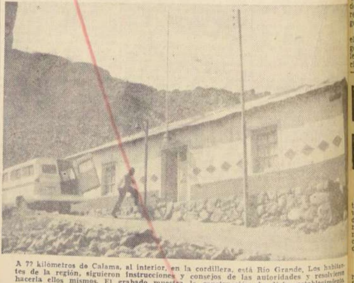
A 77 kilómetros de Calama, al interior, en la cordillera, está Río Grande. Los habitantes de la región, siguieron instrucciones y consejos de las autoridades y resolvieron hacerlos ellos mismos. El grabado muestra la construcción de dicho establecimiento.
