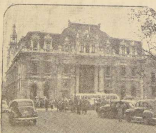
Edificio del Correo Central, ubicado en la Plaza de Armas de Santiago.
