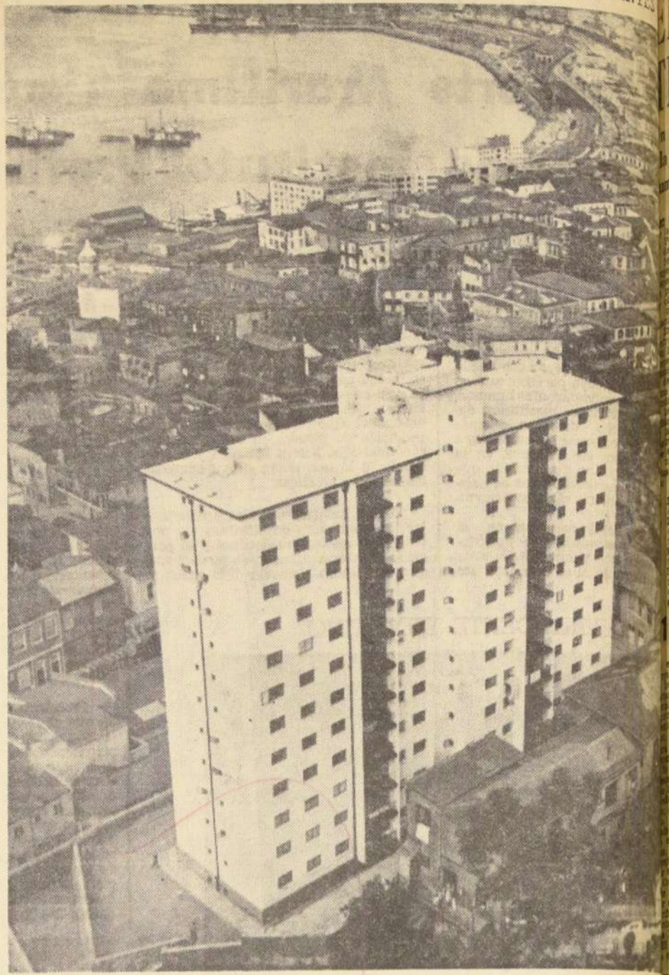
Las sobrias líneas del edificio "Monte Alegre", que levanta su blanca estructura en Cerro Alegre, Valparaíso, constituyen una valiosa contribución no solo al progreso de nuestro principal puerto, sino al bienestar del personal que labora en las actividades del
