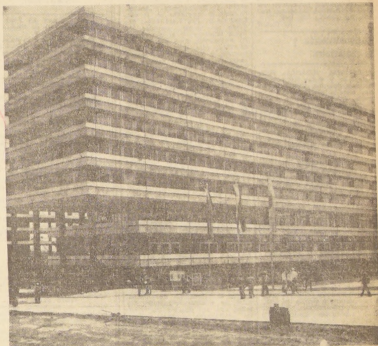
LA UNIVERSIDAD DEL RUHR.— Las primera nueva Universidad de la República Federal Alemana, cuya construcción se encuentra muy adelantada, abrió sus puertas este año. No obstante, no se espera que el total de la obra sea concluida, sino hasta 1972. La construcción de los edificios no es convencional. Se han aplicado las leyes de producción en serie, prefabricación en instalaciones sobre el propio terreno, labor programada, análisis controlados de los progresos y datos y un sistema electrónico de mejoramientos. La técnica de construcción con anclaje de acero en los elevados edificios del Instituto, permite una gran dosis de prefabricación en el taller de construcciones de acero y en la fábrica de cemento instalados en el solar. Se producen diariamente unos 600 metros cuadrados de secciones de cielo raso y 70 metros cuadrados de secciones de pasillo.
