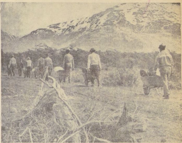
ALARGANDO LA PISTA DE RIO MEYER.— El Gobierno, a través del Ministerio de Obras Públicas, dispuso los trabajos acelerados para largar la cancha de aterrizaje de Río Meyer, y permitir bajada de aviones grandes. Desde hace tres días obreros aerotransportados desde Puerto Montt, trabajan en esa tarea de gran valor para la zona, en cuanto a abastecimiento de alimentos. En el grabado, los obreros acarrean implementos de trabajo, detrás de los técnicos encargados de las obras.
