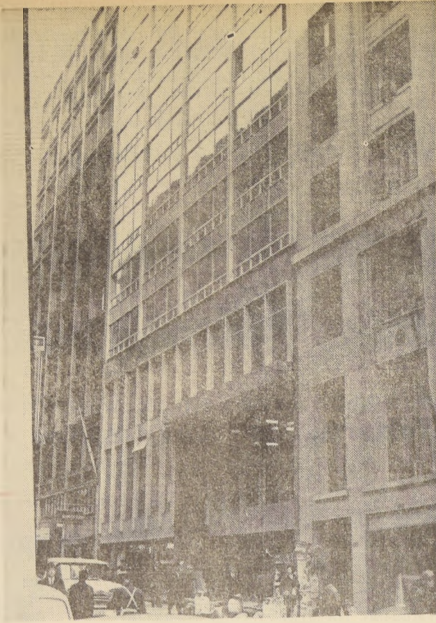
FACHADA DEL CUERPO TORRE de tres pisos, en donde funciona el Banco de Osorno y La Unión. Arquitectos: Gastón Echeverry O. y Abel Figueroa. Construido por la Empresa Guillermo Lederman y Cia. Ltda.
