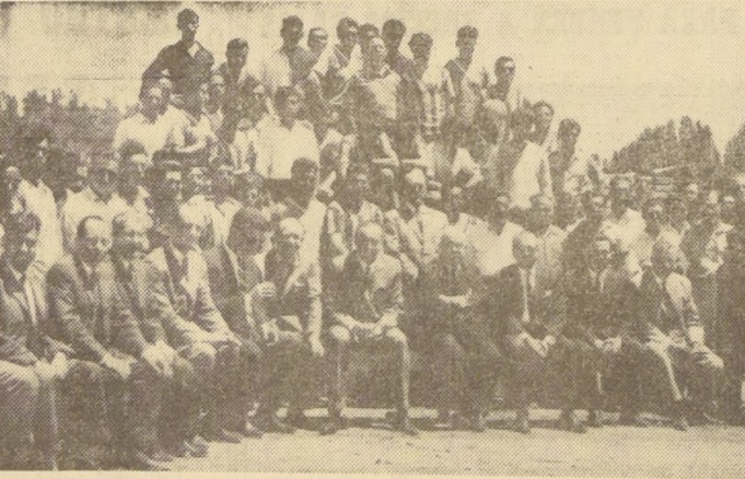
CONSTRUYERON TRAMO EN TIEMPO RECORD.— El Director General de Obras Públicas, Alfonso Díaz Ossa, acompañado del Director de Vialidad, Luis Erazo y del Jefe de Construcciones, René Birke, inspeccionó poco después del mediodía de ayer, el tramo de la Carretera Panamericana Sur, entre San Bernardo y Lo Espejo. Dicho tramo quedó terminado en el lapso de tres meses, cumpliendo de esta manera la firma Bezanilla Salinas Construcciones el compromiso contraído con el Ministerio de Obras Públicas. EN EL GRABADO, el Director General de Obras Públicas, rodeado de los Ejecutivos de la firma constructora y los obreros que ejecutaron la obra, los que fueron felicitados por el Director Díaz Ossa.
